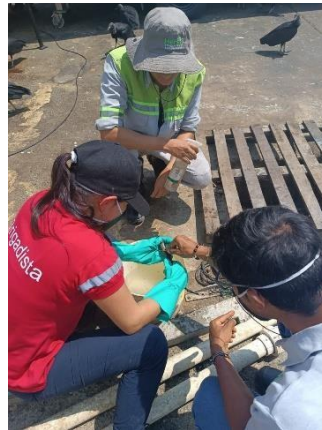
Figura 12: Revisión y cambio de la membrana lectora de oxígeno disuelto en el tanque biológico.
