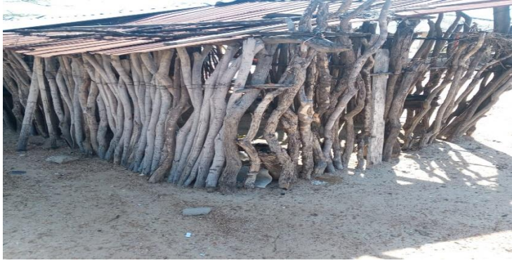
Anexo 1 I. Caseta Construida con Palos de Manglar.
