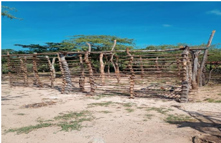
Anexo 1 H. Cerca Construida con Palos de Manglar.
