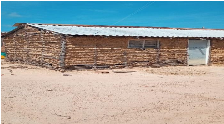
Anexo 1 F. Vivienda Construida con Palos de Manglar.
