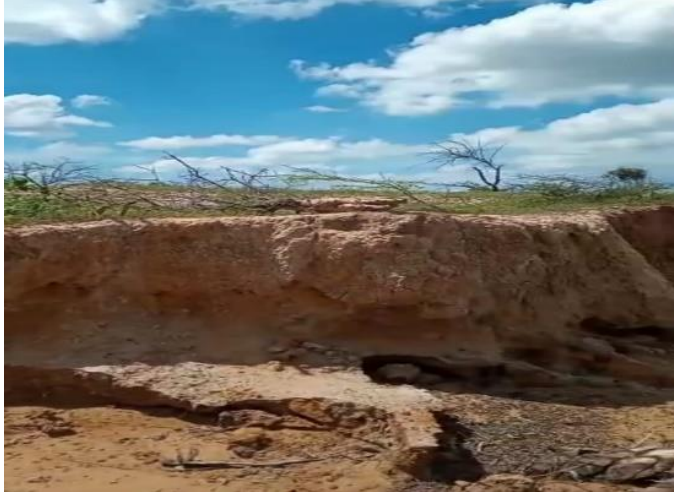
Anexo 1 W.Erosión Costera
