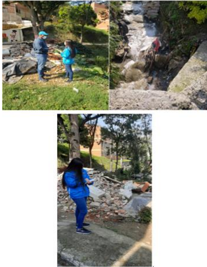
Imagen 5. Deterioro en la infraestructura vial y peatonal predisponiendo a la comunidad a múltiples riesgos.
