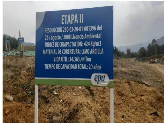
Relleno sanitario etapa 2 Autor
