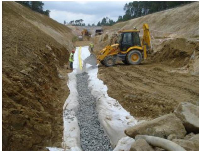
*Figura 7: Zanja de drenaje tipo French drain.*
