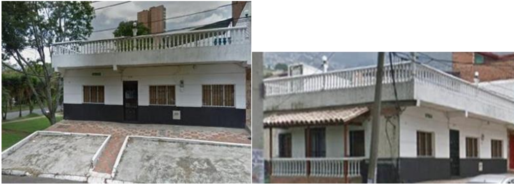
Figura 6. Vivienda seleccionada para ejercicio de certificación en eficiencia energética en edificaciones tradicionales (Quintero, L., Trujillo, J. 2020).
