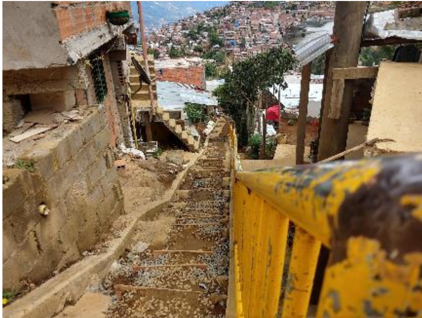
Fotografía: grupo de investigación, existen lugares en el territorio que todavía se encuentran en construcción, barrio La Honda-Comuna 3, 2019.
