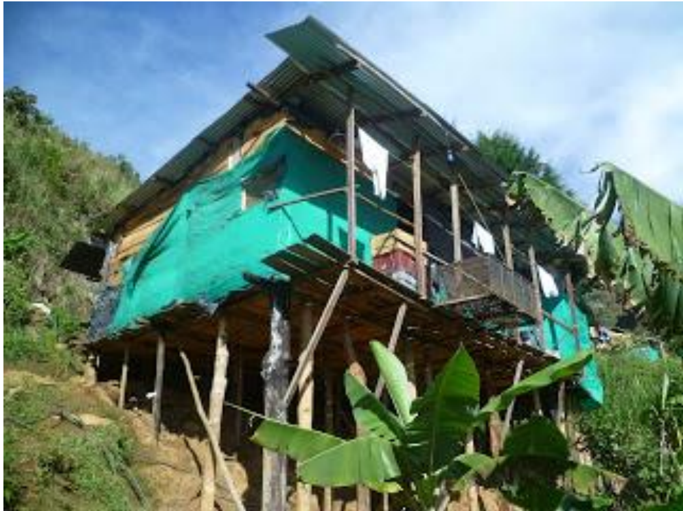
Fotografía: Construcción vivienda. Tomado de Barriolahonda.blogspot.com. La Honda, Comuna 3, Medellín.
