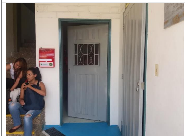
Ilustración 11. Acceso del sitio de almacenamiento de residuos de riesgo biológico
