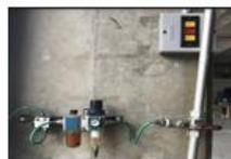
Control de aire para rampa y control de puerta
